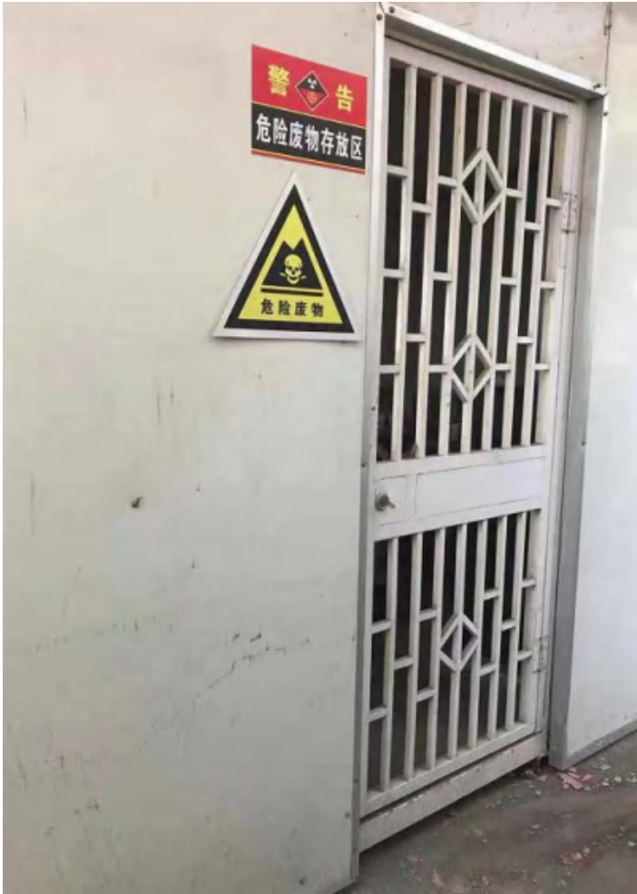
图 4-5 本项目危废仓库图片
